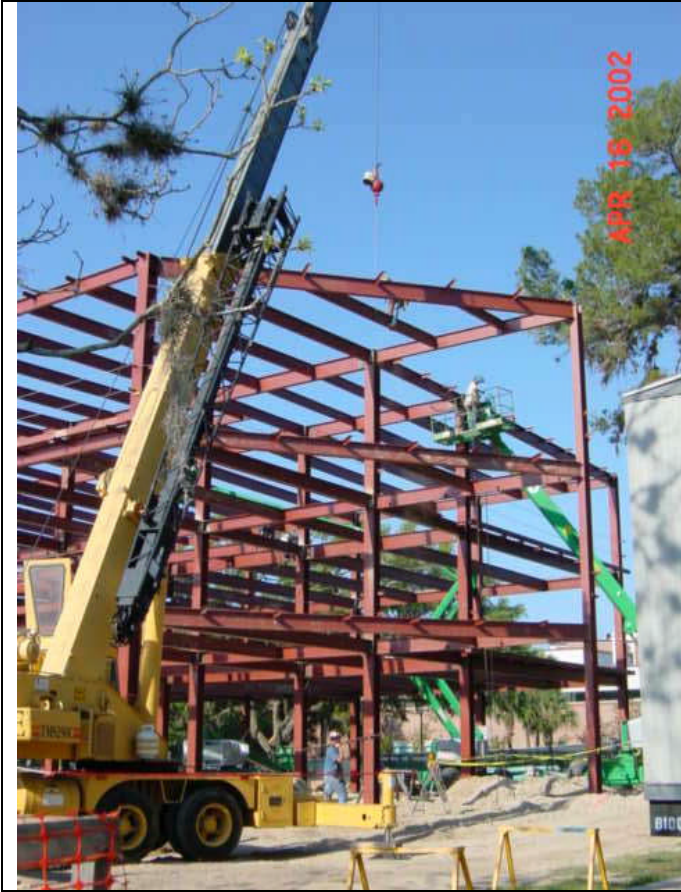
Topping out small JPEG.JPG
