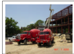
Cox Concrete pouring the 3 rd floor slab.
