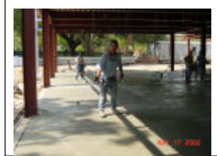
Concrete Pour at Slab on Grade
